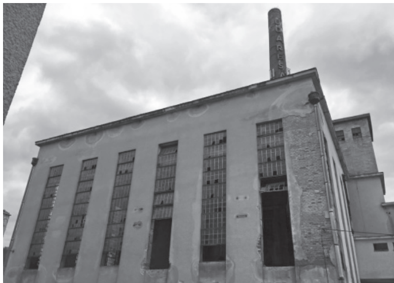
■ Slika 2. Bivša električna centrala izgrađena 1930. prema nacrtima karlovačkog arhitekta Filipa Hekša. U pozadini je dimnjak visok 75 m, prepoznatljiv element u veduti grada. [3]
