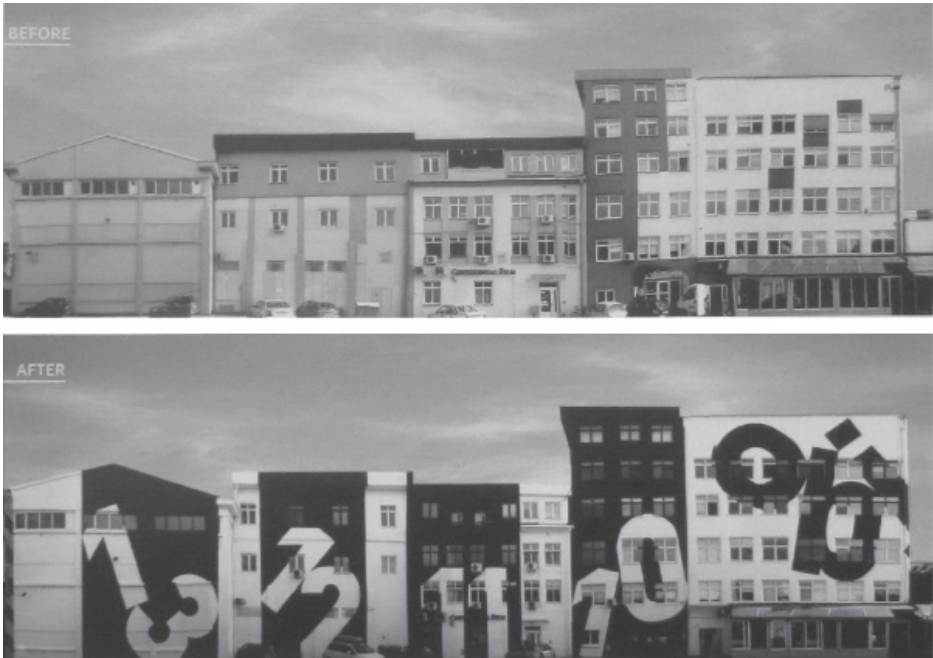
■ Slika 4. Sjeverno pročelje Tvornice papira na Zavrtnici prije i nakon obnove
