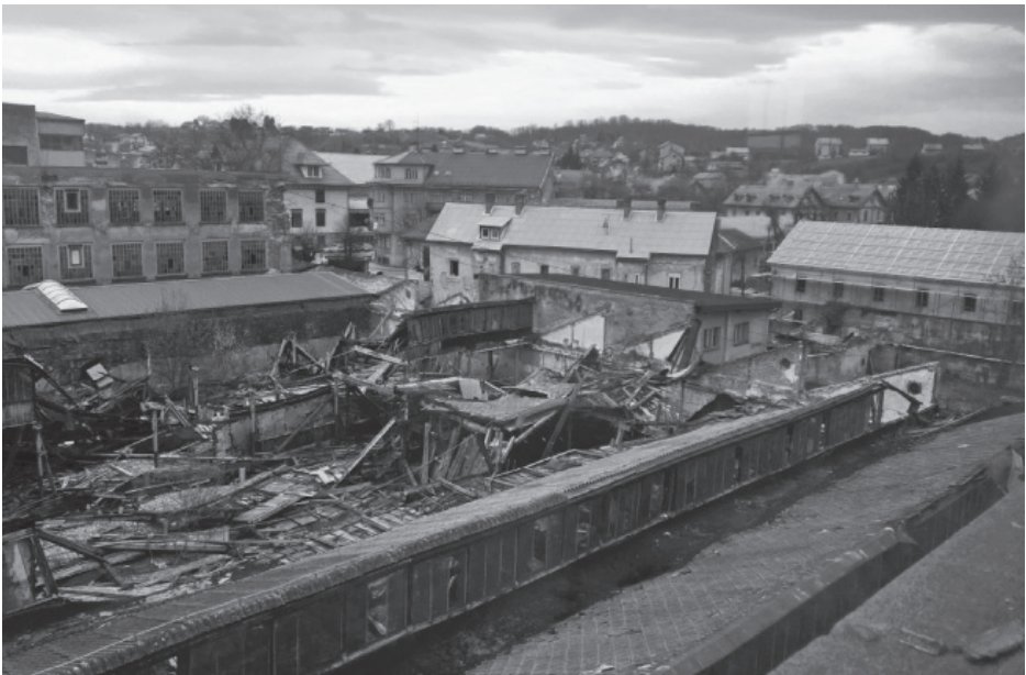
■ Slika 4. Postojeće stanje nekadašnjeg shed krova u zgradi tkaonice [3]
